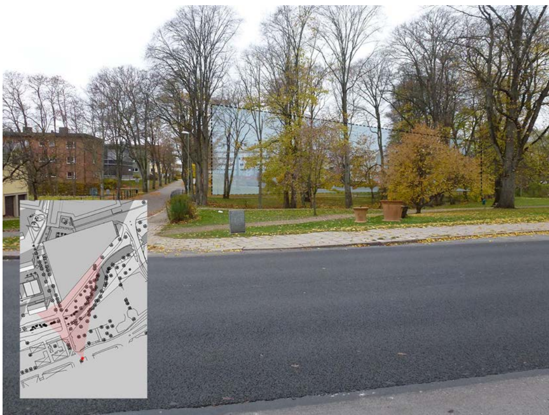
Bilden är tagen från Västerlånggatan väster om Stadshotellet mot sjukhusområdet.
