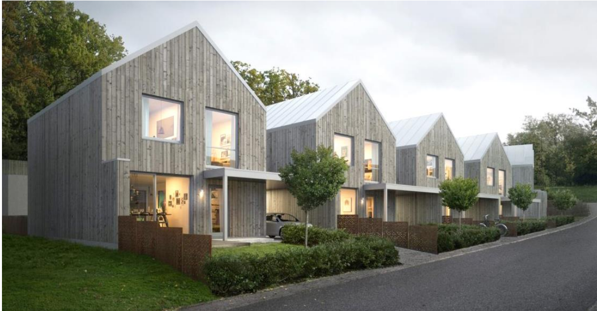
Figur 36 Högmora 2:24 i Huddinge har en enhetlig färgsättning baserad på trä som behandlats med järnvitriol. Fasadmaterialet visar sina egenskaper och integreras med landskapet på ett naturligt sätt. Bildkälla: Imola.se
