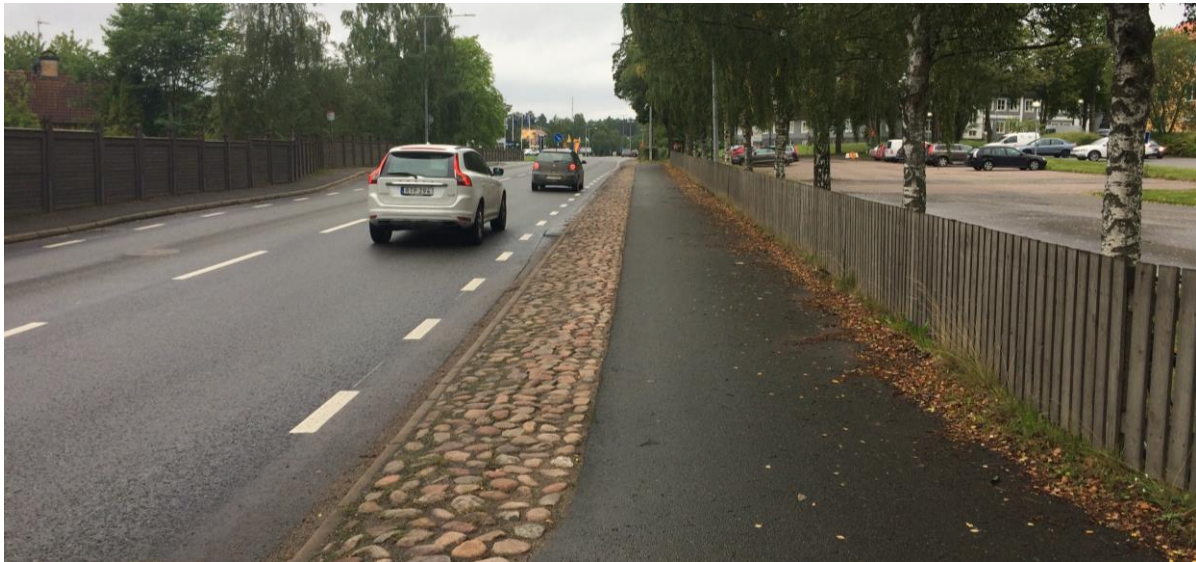
Figur 11 GC-väg vid riksväg 40
