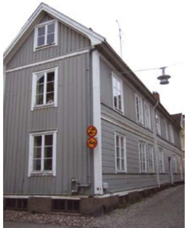
Fasader mot öster och norr
