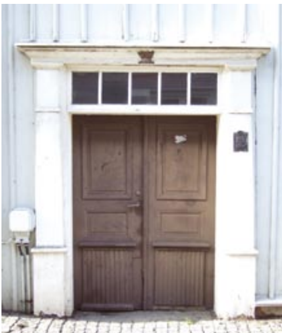
Ytterdörr till handikapptalett mot Norra Storgatan
