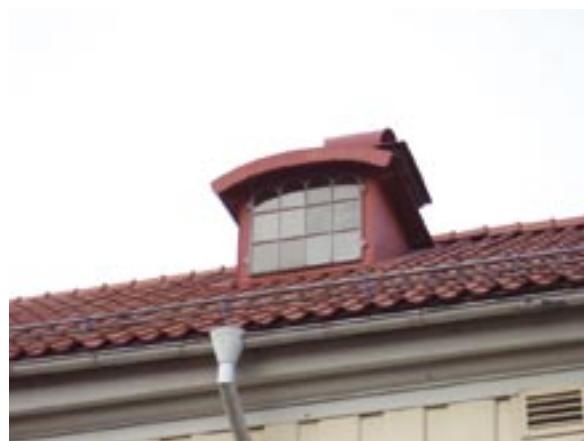
Vindsкупа på tak mot gården
