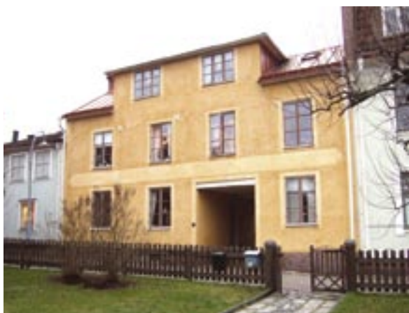
Fasad mot Arendt Byggmästaresgata
