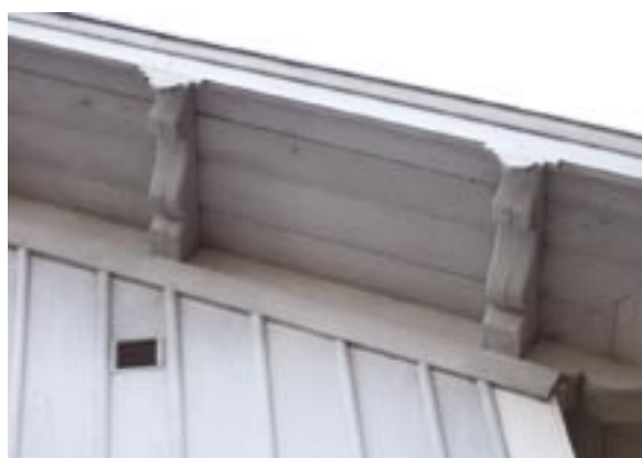
Takföt vid gavel mot norr
