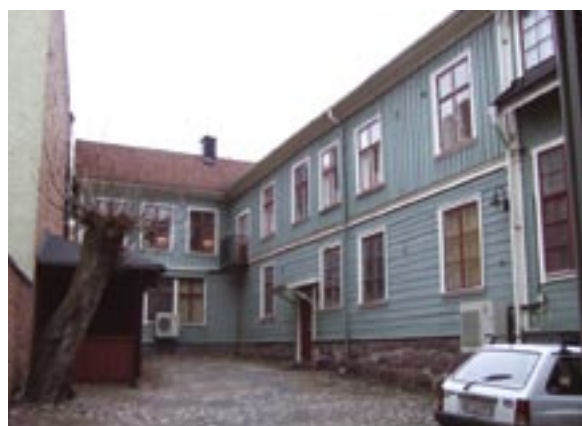
Fasad mot väster och norr
