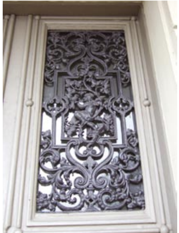
Detalj av ytterdörr mot Stora Torget
