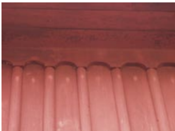
Fasaddetalj under takfot
