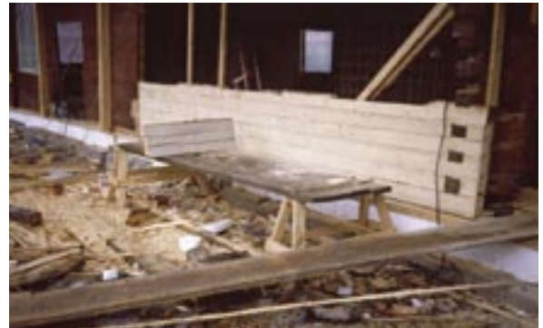
Restaureringen 1989. Fasad mot söder
