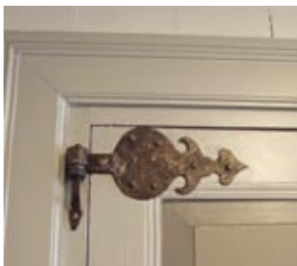
Dörrgångjärn i entréhall
