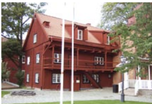
Museibyggnad 1 mot söder.
