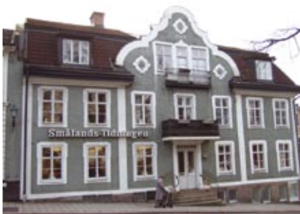
Fasad mot Stora Torget
