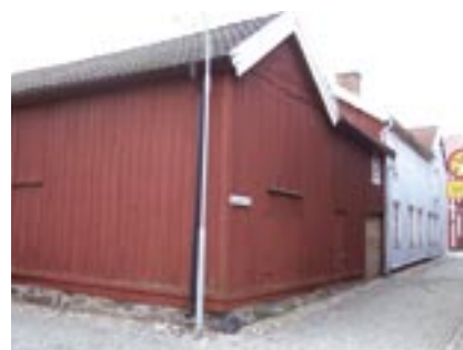
Fasader mot öster och norr
