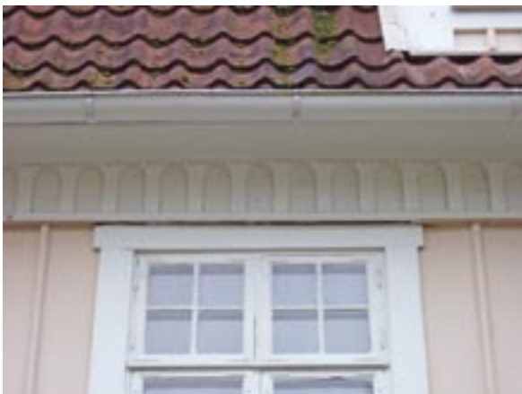
Löpande rundbågefris under takfoten mot öster på bostadsbyggnaden
