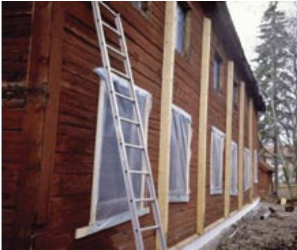
Restaurering av fasaden mot norr 1989
