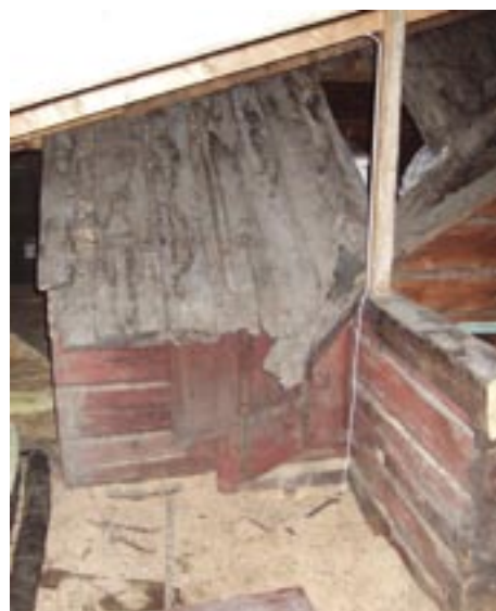
Kvarvarande ursprunglig yttervägg mot gårdssidan. Röd målade fasader, faltak (spårade takbrädor) och rännal av urgröpt stock
