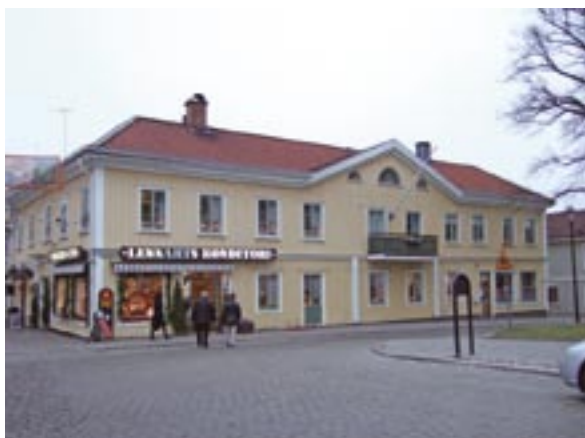
Fasad mot Stora Torget
