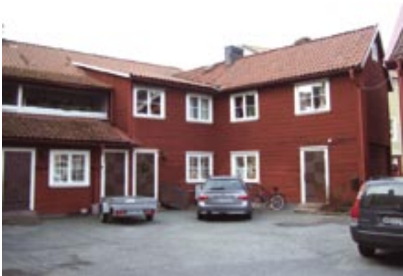
Gårdsfasader mot öster och söder.
