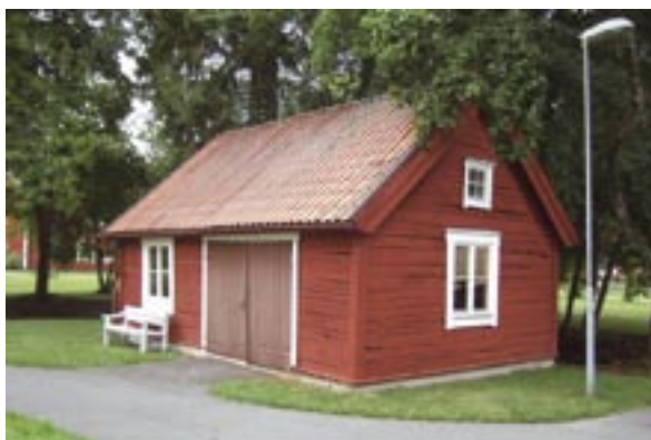
Fasader mot söder och öster
