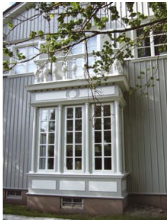
Burspråk mot söder
