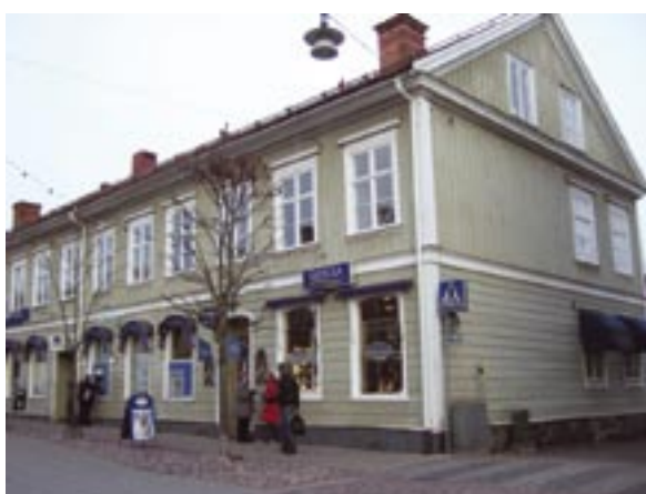
Fasad mot Södra Storgatan
