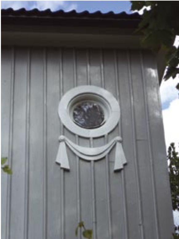
Fasaddetalj(festong) på fasad mot väster
