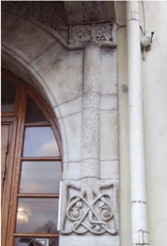
Detalj på omfattning kring ytterdörrparti
