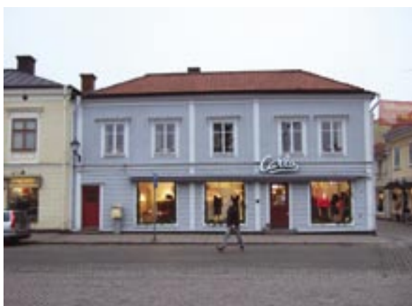
Fasad mot Stora Torget
