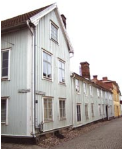
Fasad mot Arendt Byggmästaresgata
