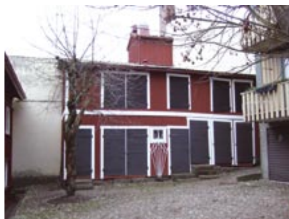
Uthusbyggnad med fasad mot norr
