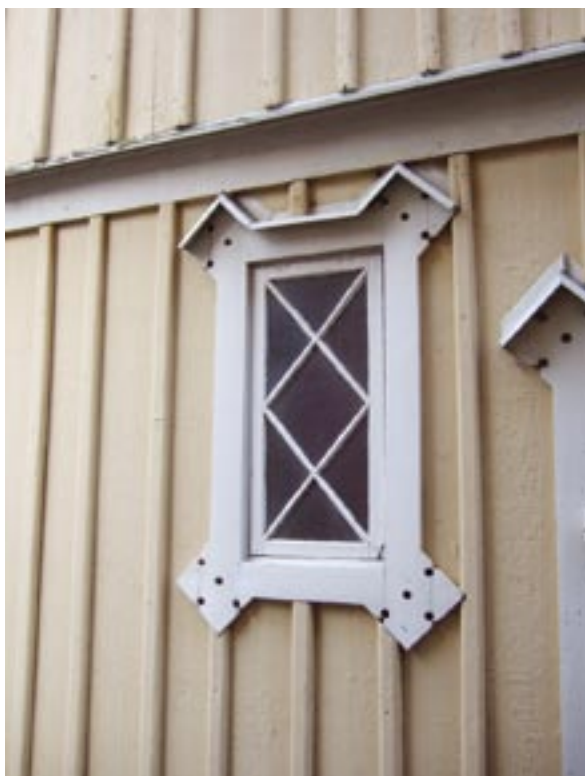
Fönsterdetalj på uthusets gavel mot söder
