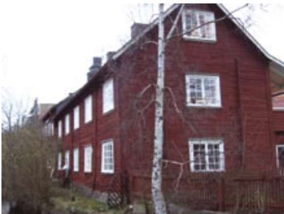
Fasader mot söder och öster
