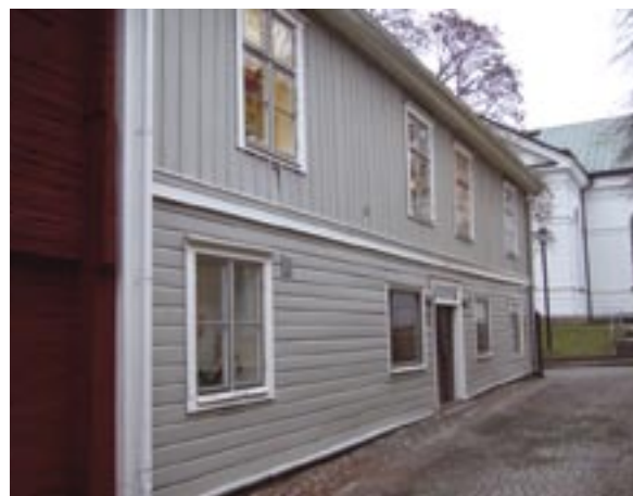
Fasad mot Arendt Byggmästaresgata
