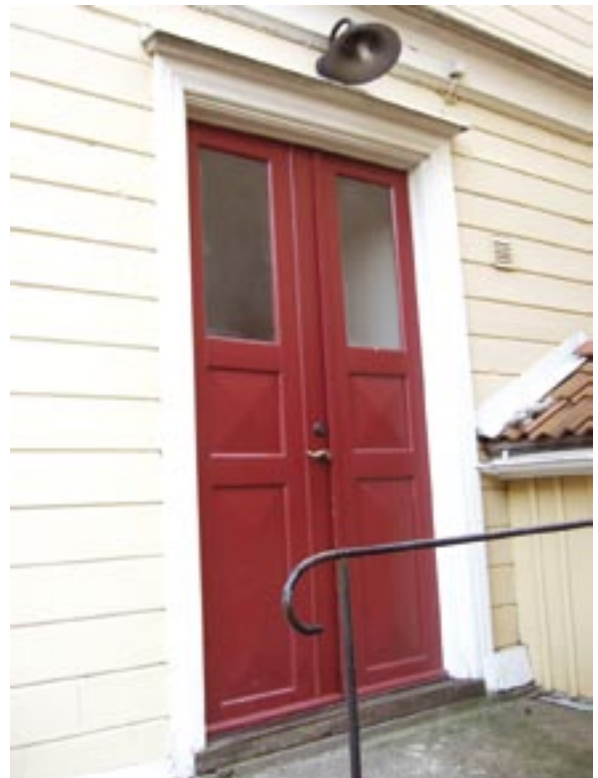
Entrédörr mot norr
