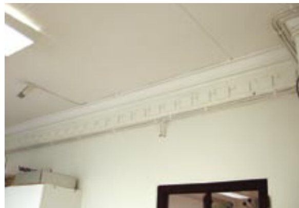
Samma tandsnitt invändigt på väggparti som tidigare varit yttervägg.
