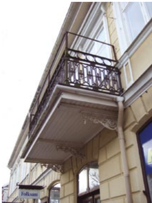
Balkong mot Södra Storgatan
