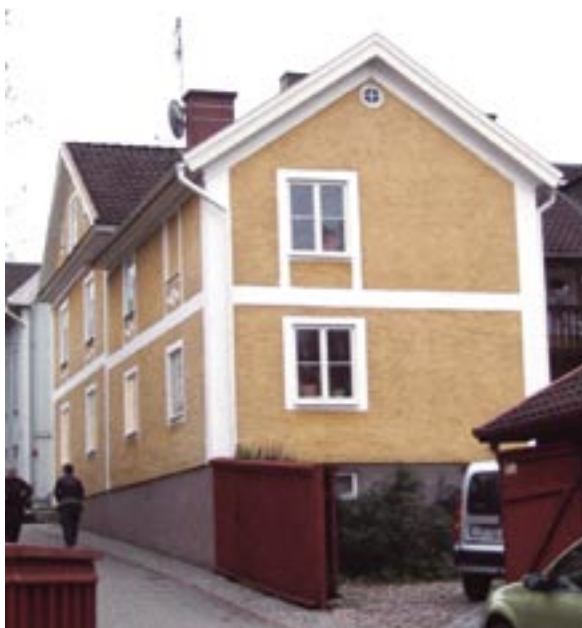
Fasader mot söder och öster
