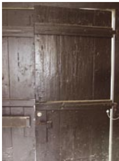
Insida av port mot Arendt Byggmästares gata
