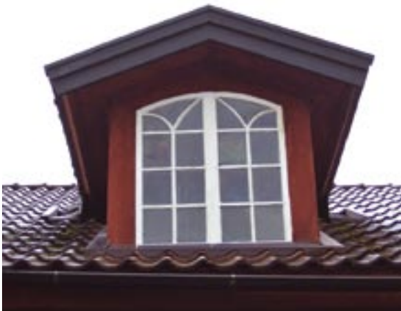
Takkupa mot norr på gårdsbyggnad
