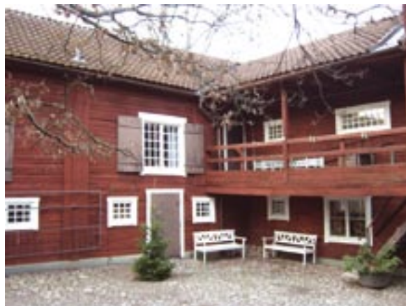
Fasad mot öster och söder
