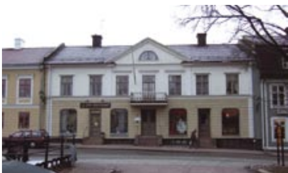
Fasad mot Stora Torget
