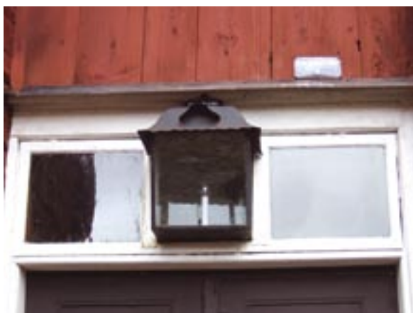
Lampa över gårdsentré
