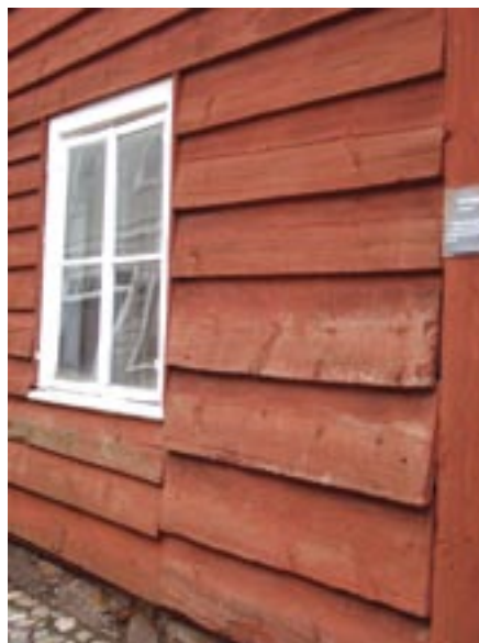
Fasadbräder på s.k. förvandling mot Arendt Byggmästares gata
