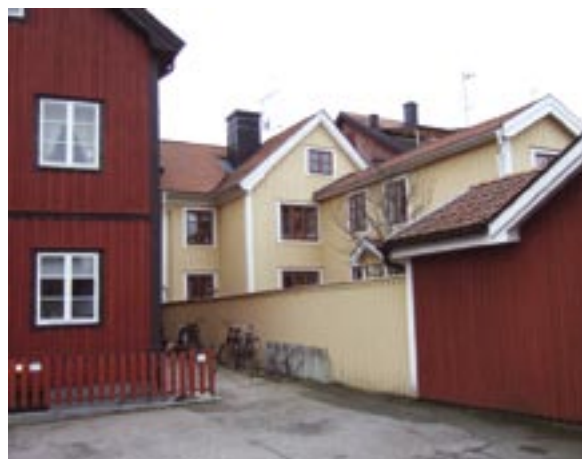
Gårdsfasader mot norr och väster
