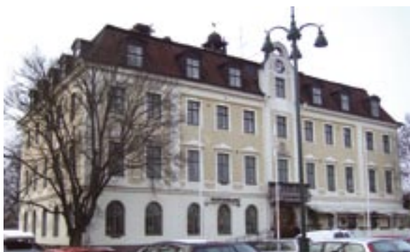
Fasad mot Stora Torget
