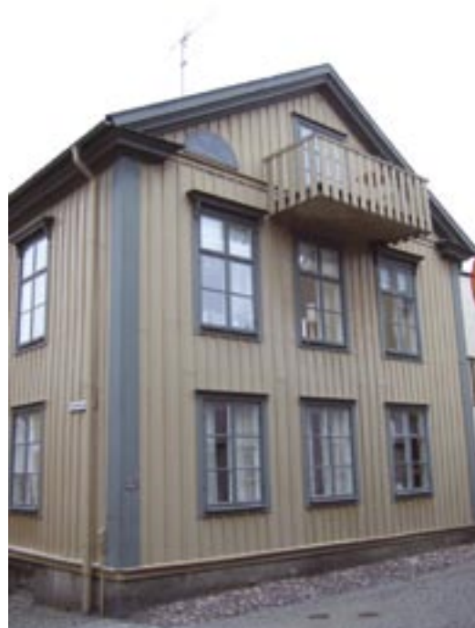
Fasad mot Arendt Byggmästaregata
