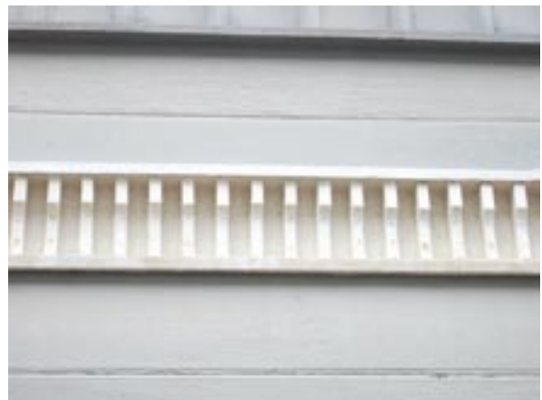
Snickeridetaljer på fasad mot norr
