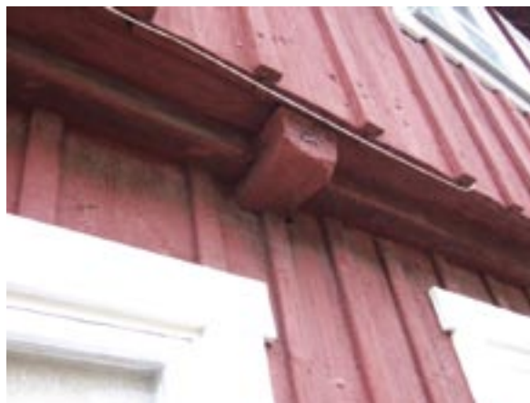
Detalj av den s.k. skunken på fasad mot Arendt Byggmästaresgata
