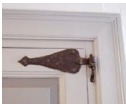
Dörrgångjärn i entréhall
