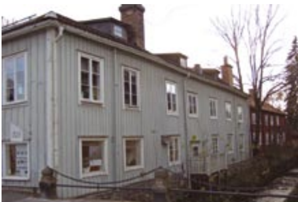
Fasad mot norr och ån.
