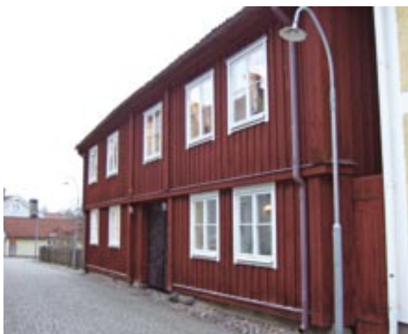
Fasad mot väster
