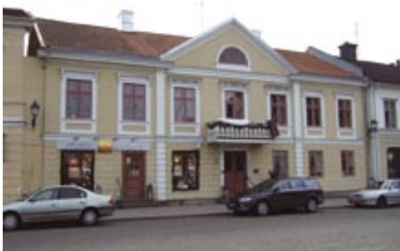
Fasad mot Stora Torget
