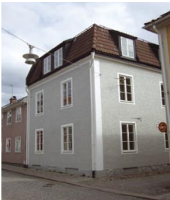
Fasader mot Norra Storgatan och Bleckslagaregränd
