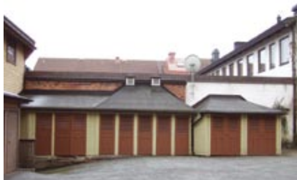
Fasader mot norr
