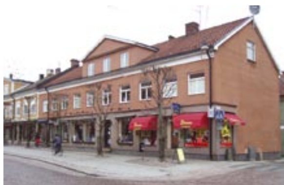
Fasader mot Södra Storgatan och Jungfrugatan
