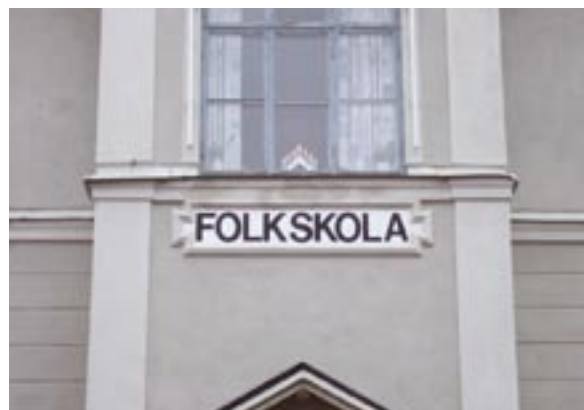
Fasaddetalj mot väster
