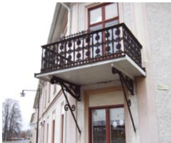
Balkong mot sydöst
