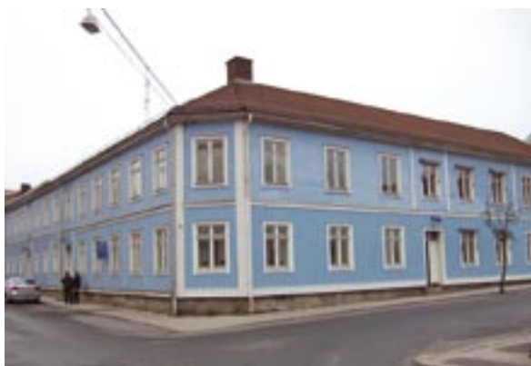
Fasader mot Köpmangatan och Österlånggatan
