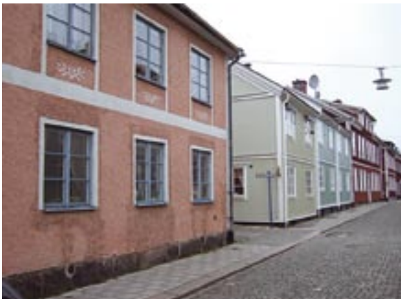
Nuvarande fasader utefter Norra Storgatan, norrut, västra sidan
