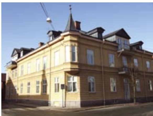
Fasader mot Köpmangatan och Österlånggatan
