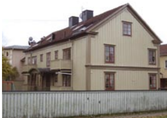
Fasader mot öster och norr
