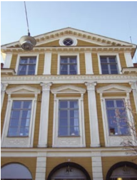
Fasaddetaljer mot Södra Storgatan
