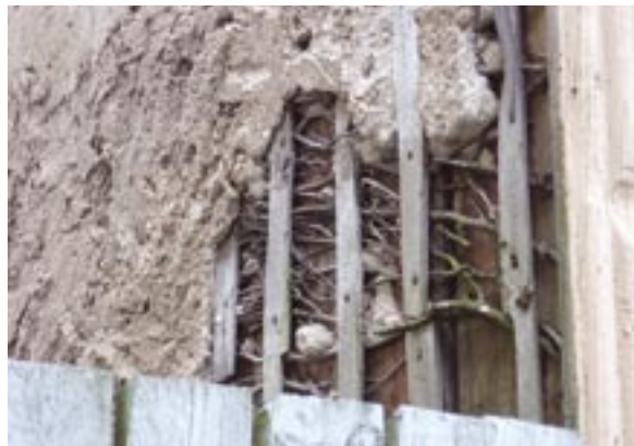
Fasaddetalj mot norr
