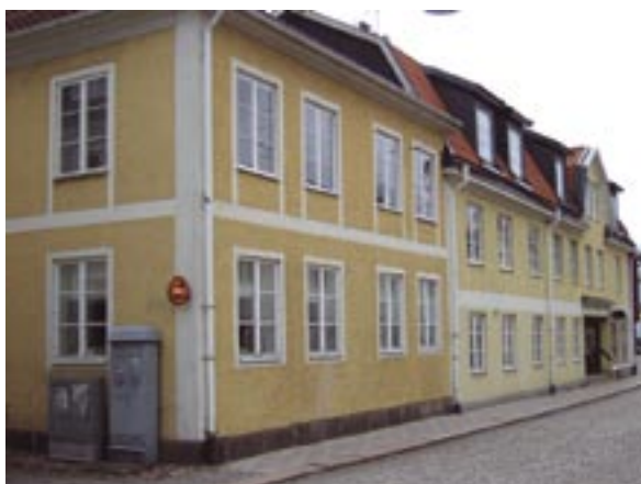
Fasader mot Bleckslagaregränd och Norra Storgatan
