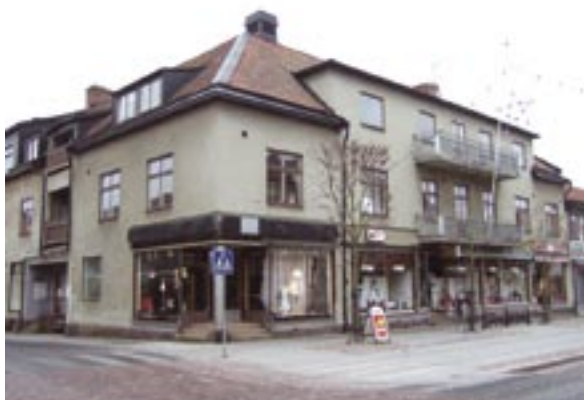
Fasad mot Jungfrugatan och Södra Storgatan
