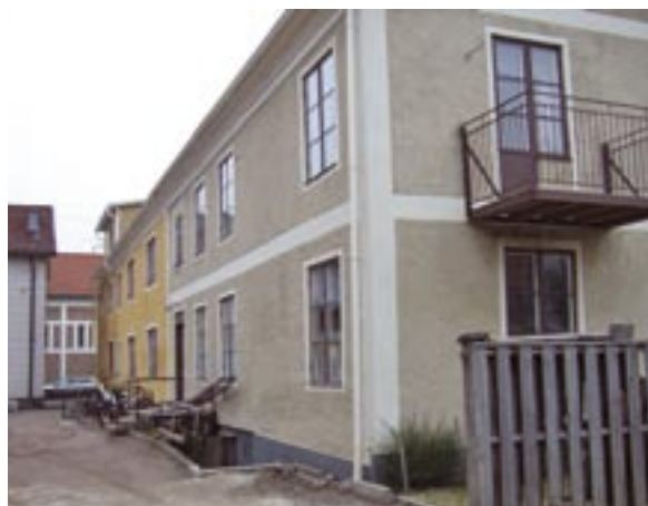
Fasader mot söder och öster
