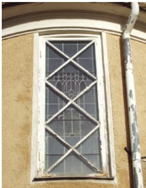
Blyinfattat fönster mot väster
