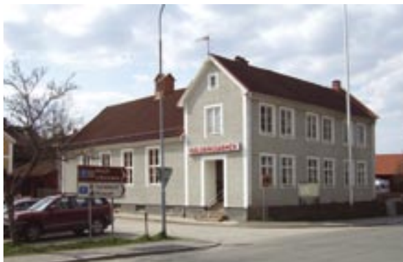
Fasader mot söder och öster
