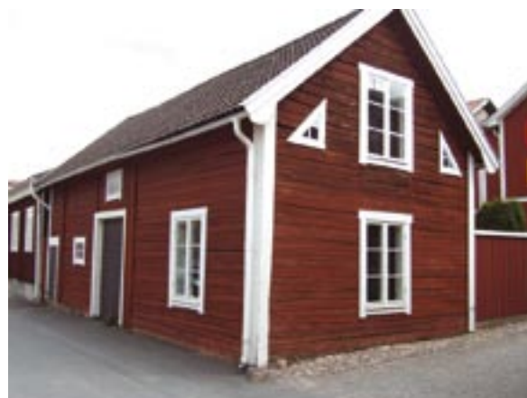
Fasad mot Västra Bakgatan och söder
