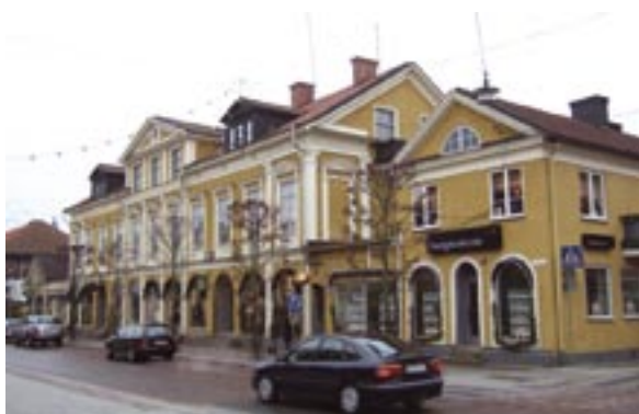
Fasad mot Södra Storgatan
