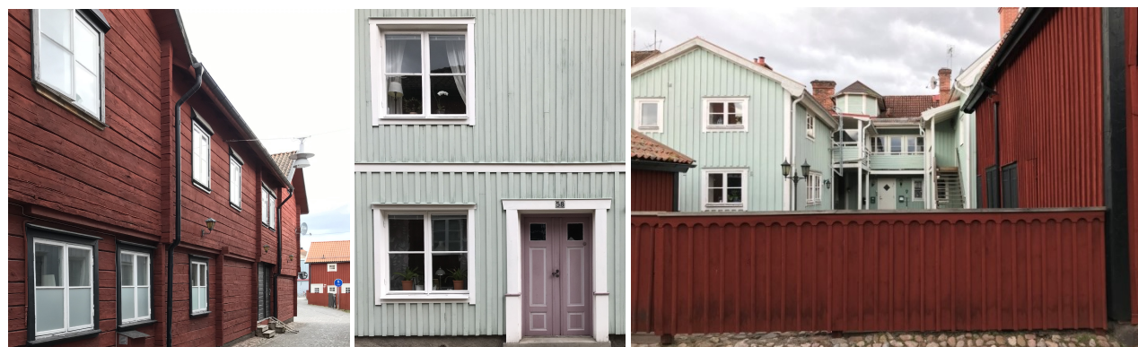
Från vänster; Del av Kassamannen 1 från Skomakargränd. Huvudentrén mot Södra Storgatan, respektive bakgården för Kassamannen 4 sett från Östra Bakgatan. Gårds- och komplementbyggnader har ett uttryck av äldre och möjligt mer ursprunglig karaktär än huvudbyggnaderna.
